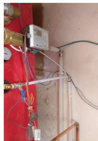
FIGURA 9: MEDIDOR DE ENERGÍA TANQUE PRODUCCIÓN SOLAR
