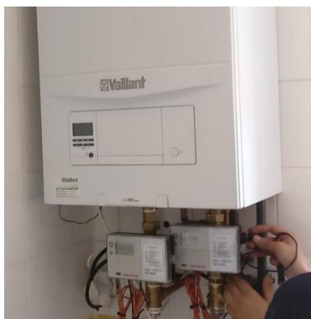
FIGURA 8: MEDIDOR DE ENERGÍA (CALOR Y ACS)
