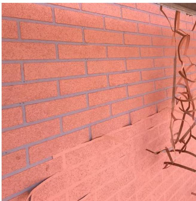
FIGURA 13. DETALLE DEL ACABADO EFECTO LADRILLO EN EL SATE EN EL EDIFICIO DE SARASATE 5
